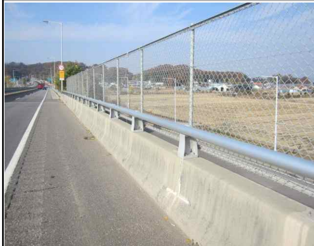
난간 및 연석 전경
